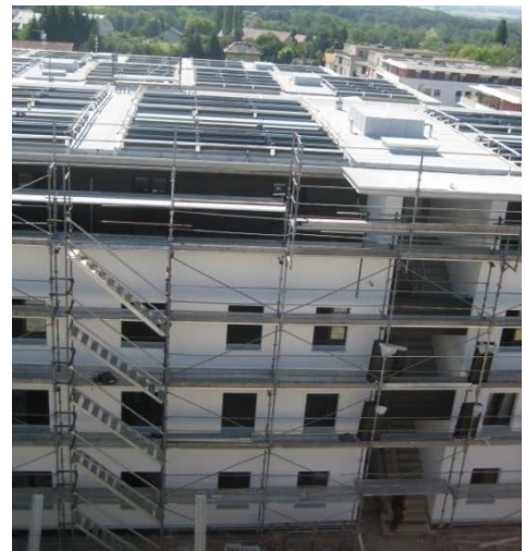
Figure 6: Les Cépages en construction
