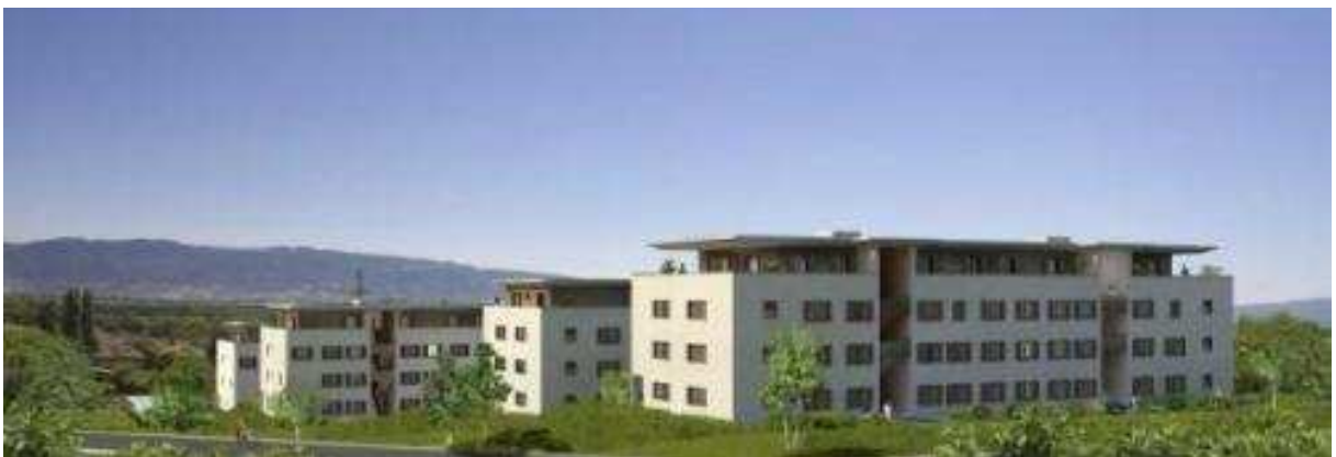
Figure 4: Façades nord de l'ensemble des bâtiments
